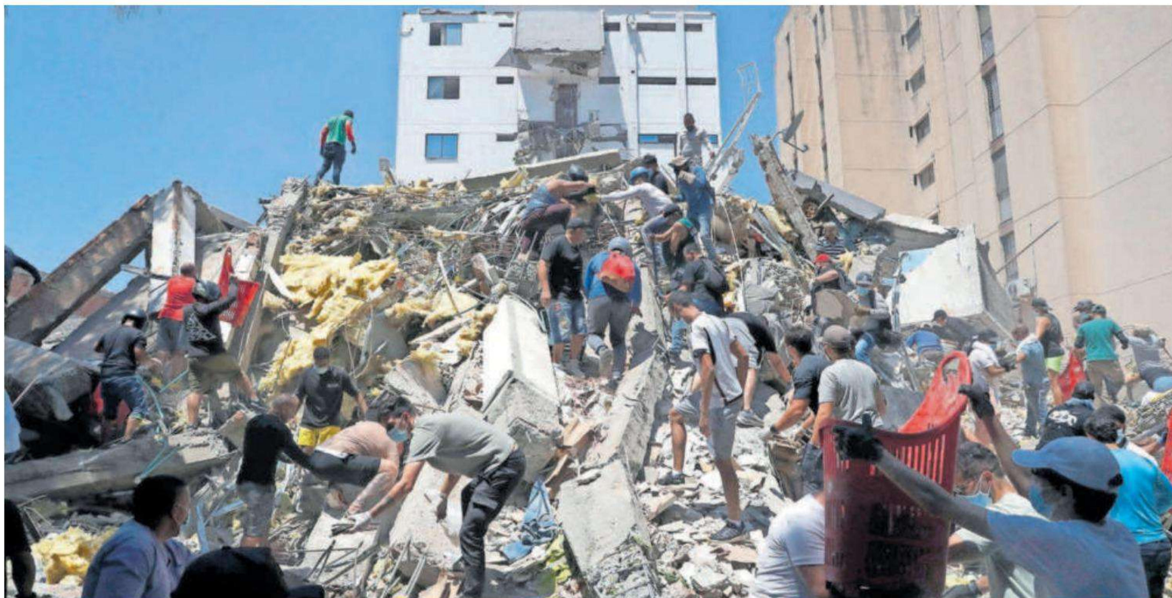
Bomberos y civiles buscaban ayer supervivientes entre los escombros de edificios que colapsaron por el terremoto en Cali. ERNESTO GUZMÁN JR (EFE)
